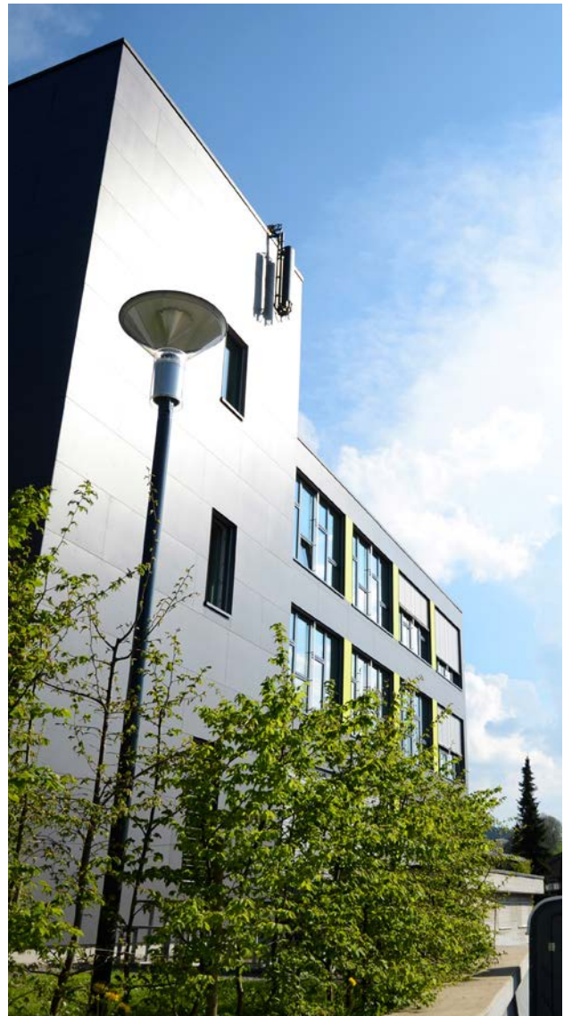
Bürogebäude ARI in Herisau
